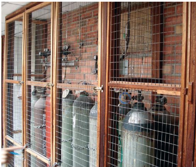
شکل ۴-۱۷: انبار سیلندرهای گاز
