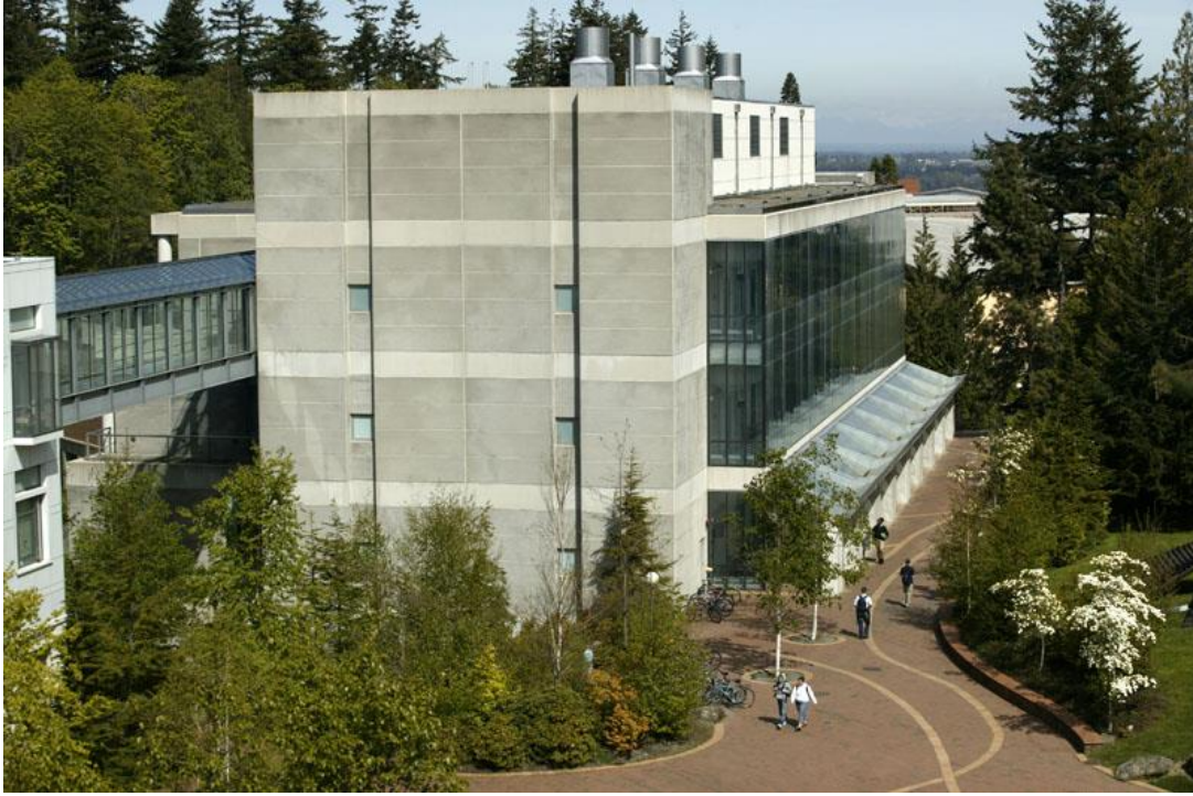
شکل ۱-۵ ساختمان مجتمع آزمایشگاهی
