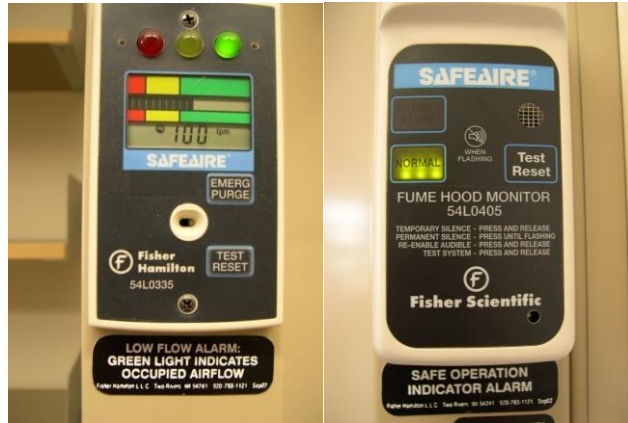
شکل ۲-۱۲ سمت راست آلارم وضعیت درب و سمت چپ آلارم جریان هوا
