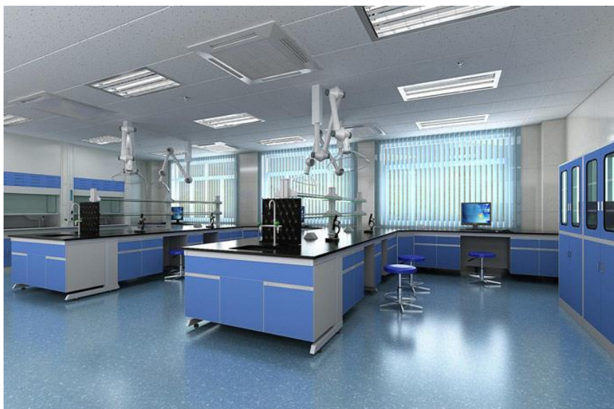
شکل ۱-۱۲ آرایش مناسب سیستم‌های تهویه در سقف
